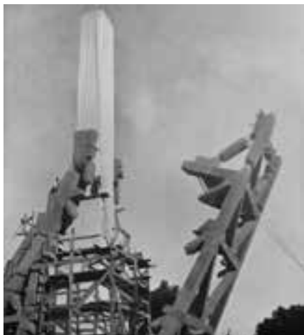
Afb. 5 Het verwijderen van de installatie om te obelisk op te richten. Bron: ONB (1937: 242).
