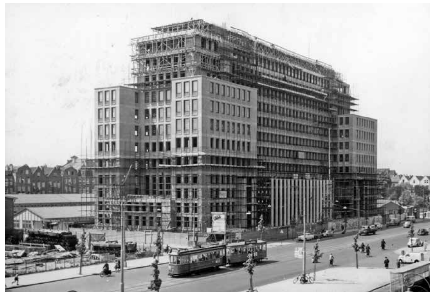
Rijksbelastingkantoor in aanbouw, Amsterdam, omstreeks 1956 (SAA/Anefo).
